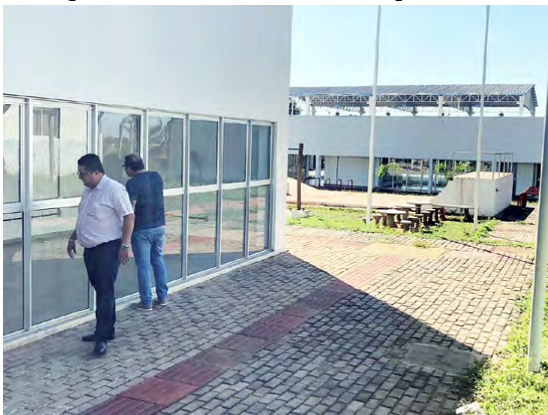
O prédio conta com recepção, salas de atendimento, duas salas multiusos, copa e banheiro
