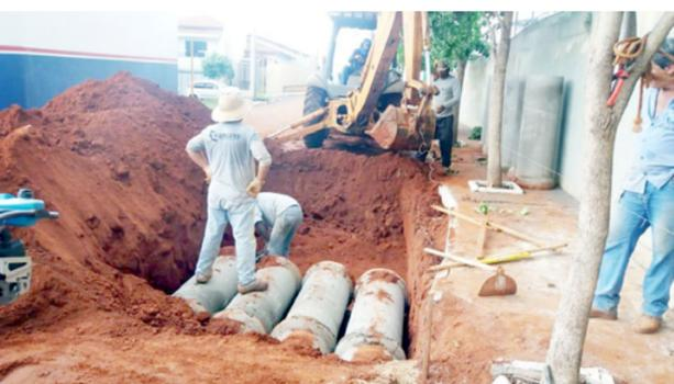
A reforma na UPA de Jales inclui a transferência das galerias de águas pluviais que supostamente implicaram em danos na estrutura do prédio
