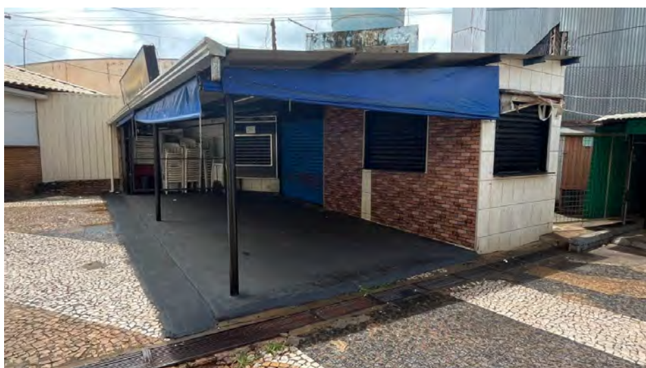
Imagem 02: Trailer Fixo de Lanches, localizado na Avenida Angelo Miotto, nº 50, no Lanchódromo Municipal.
