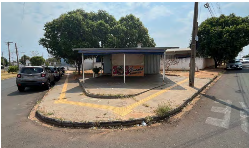
Imagem 1: Trailer localizado em espaço público, situado a Rua Sebastiana Jesus Silva, Nº 246
