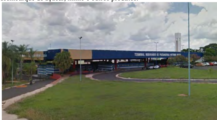
Figura 19. Terminal rodoviário de Fernandópolis.
