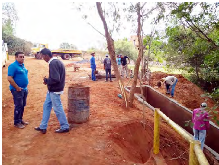
Serviço vem sendo realizado com mão-de-obra da própria Prefeitura de Fernandópolis
